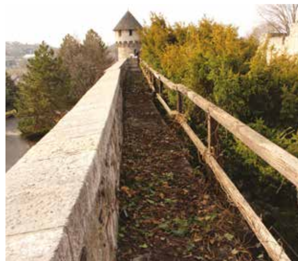
Déli gyilokjáró felújítás előtt
