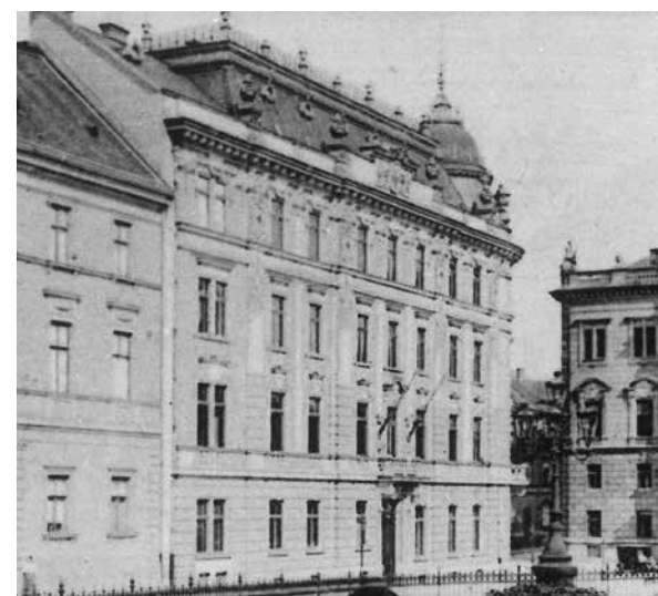
Az épület nyugati homlokzata, 1910 körül
